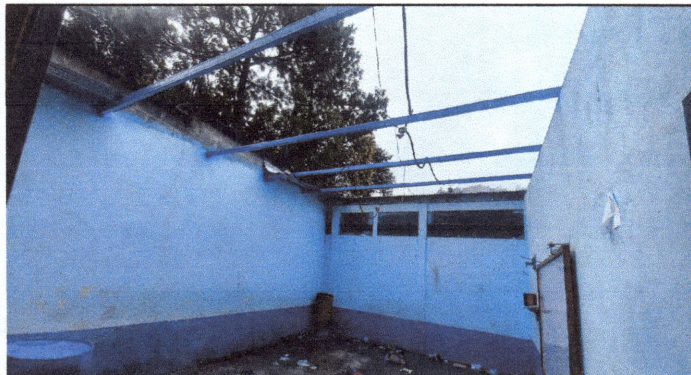
Foto 3: Aula del módulo 4, Mantenimiento en proceso a estructura de techo, remoción de óxido y aplicación de pintura anticorrosiva azul.
