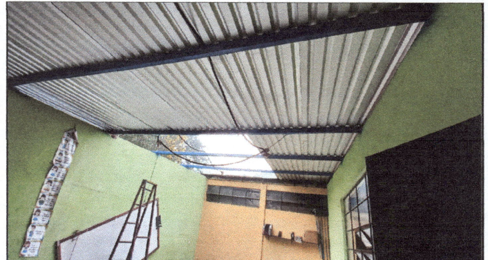
Foto 2: Aula del módulo 4, en proceso de instalación de lámina troquelada.
