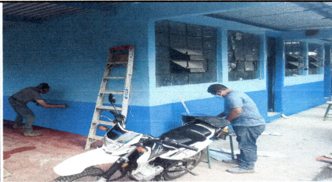
Foto 9: Módulo 4, Se observa proceso de aplicación de pintura en paredes de aula.
