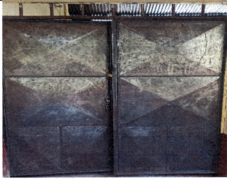
Foto 7: Módulo 4, Se observa proceso de pulido de portón, para aplicarle pintura anticorrosiva.
