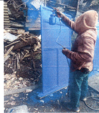
Foto 8: Proceso de restauración de puertas de baño.
