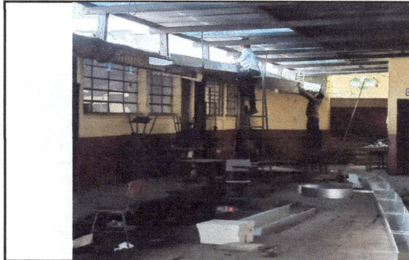
Foto1: Instalación de pescantes que soportará canales de lámina lisa.
