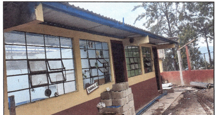
Foto 4: trabajos en proceso de sustitución de cubierta de lámina módulo 4, e instalación de canal y bajada de agua pluvial.
