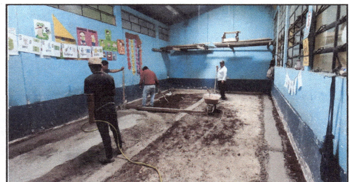
Foto 6: Aula 1 de módulo 3, se observa proceso de compactación de suelo, y cambio de torta de concreto
